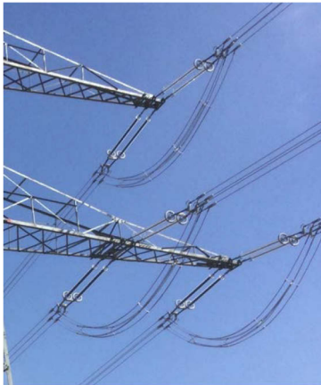
Abbildung 24: 380-kV-Doppelabspannketten für 4er-Bündelleiter
