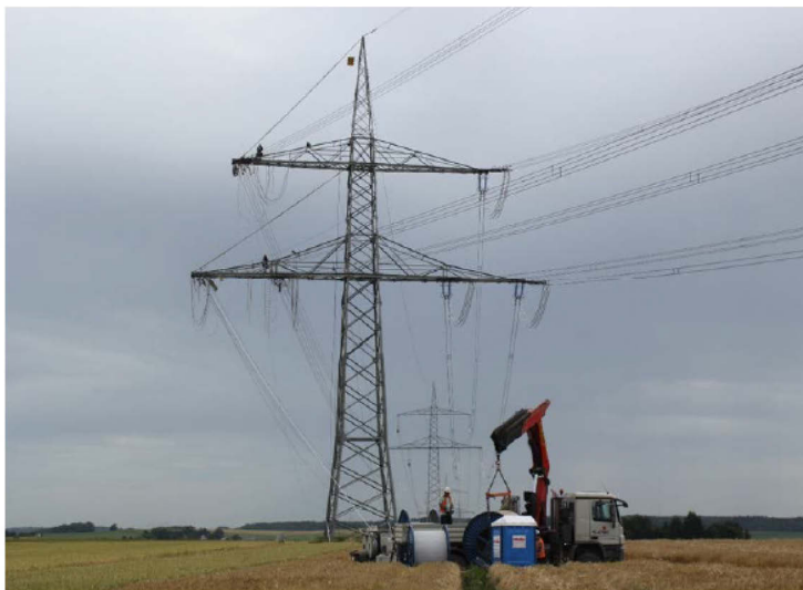
Abbildung 39: Seilzugarbeiten an einem Trommelplatz
