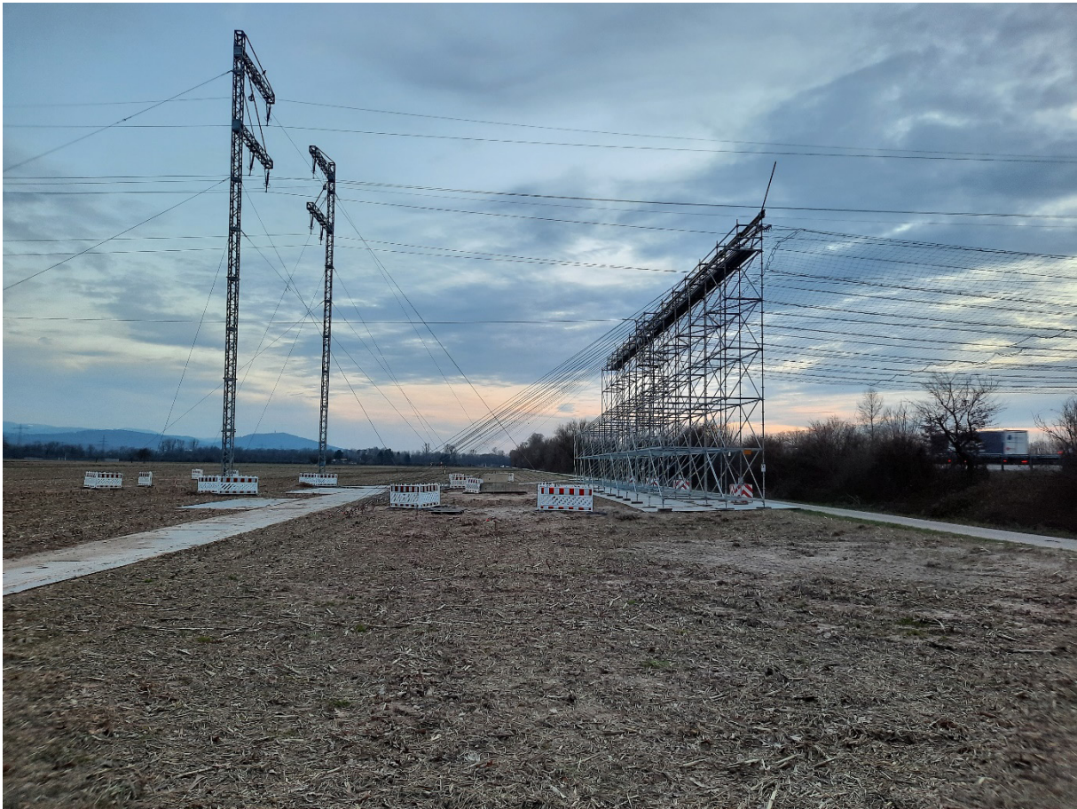
Abbildung 49: Beispiel für ein Provisorium und Schutzgerüst mit Ankerseilen Quelle: LTB Leitungsbau GmbH
