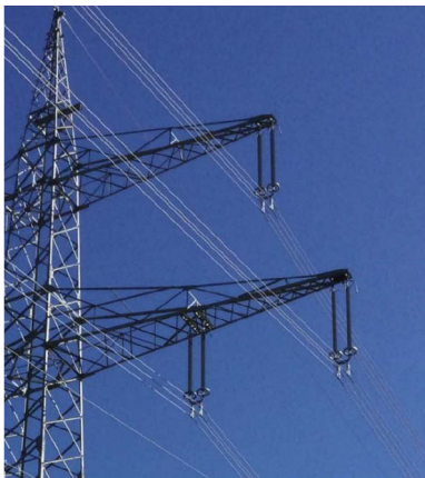
Abbildung 25: 380-kV-Doppelhängeketten für 4er-Bündelleiter
