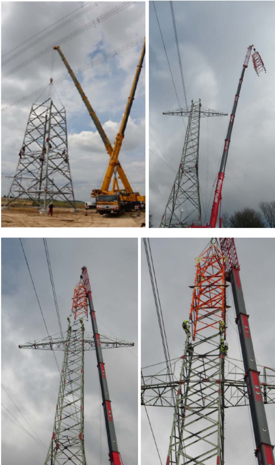
Abbildung 36: Maststocken mit Mobilkran
