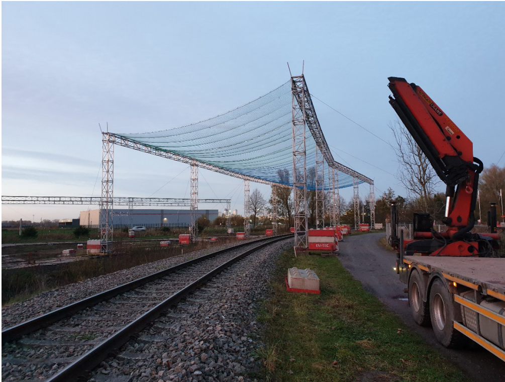
Abbildung 45: Schutzgerüst mit Auflastgewicht über Bahntrasse Quelle: LTB Leitungsbau GmbH
