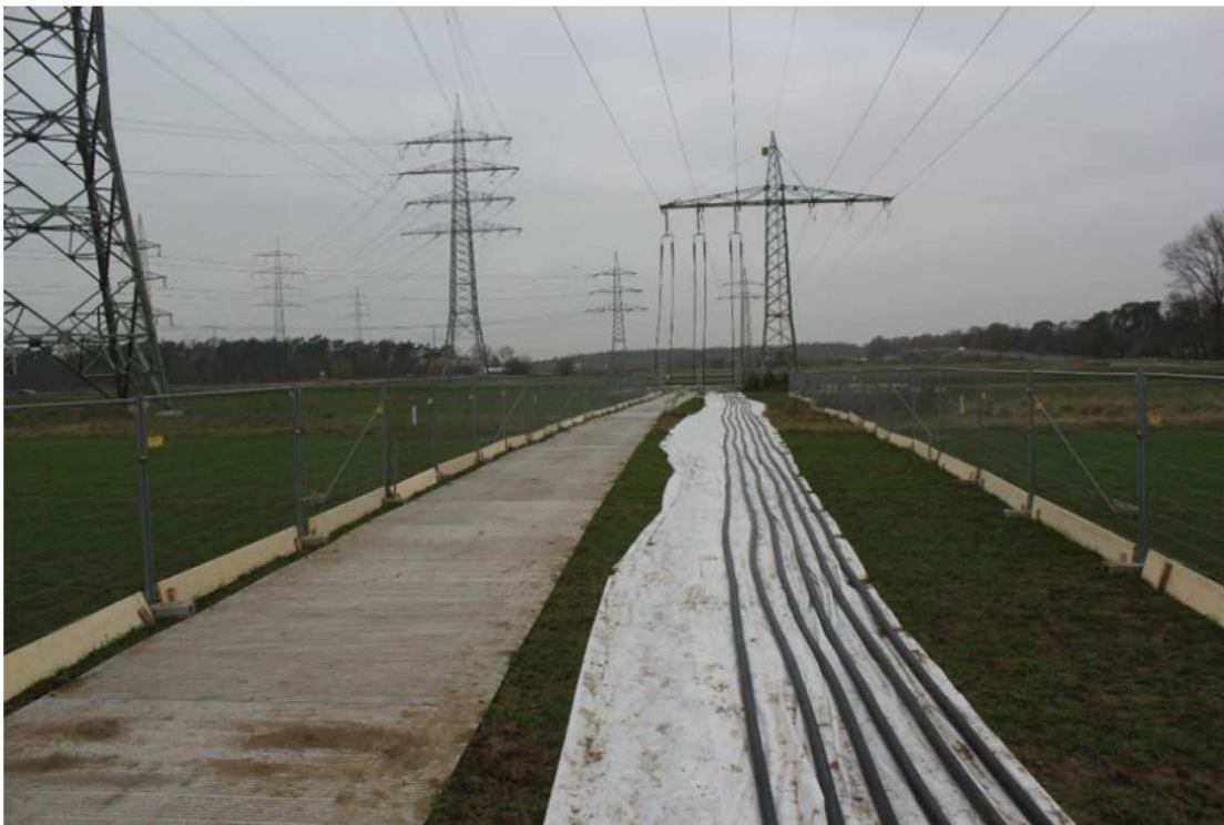
Abbildung 52: Beispiel eines Baueinsatzkabels (110-kV)
