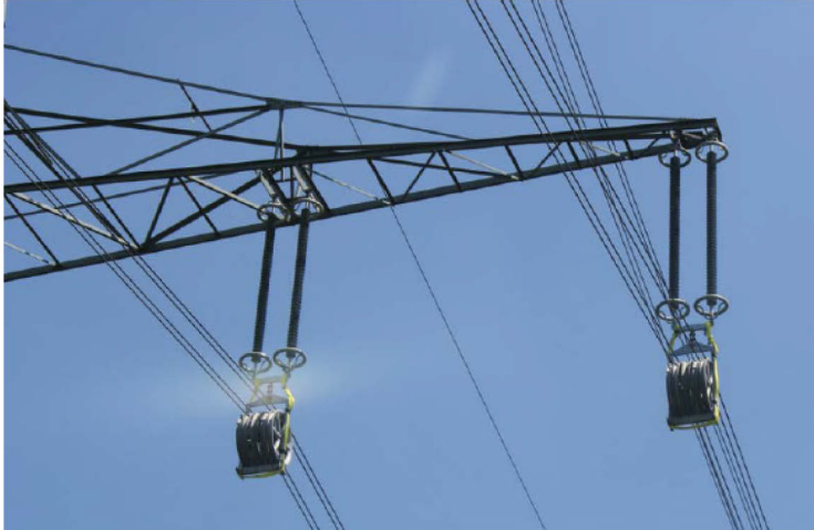
Abbildung 38: Seilrollen an Isolatorketten befestigt
