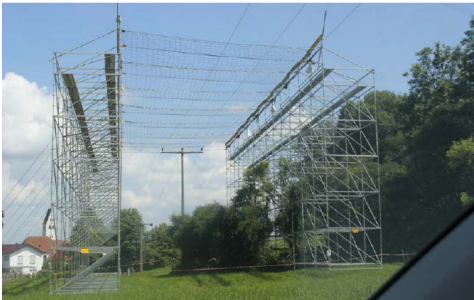
Abbildung 46: Schutzgerüst mit Ankerseilen über Niederspannungsleitung
