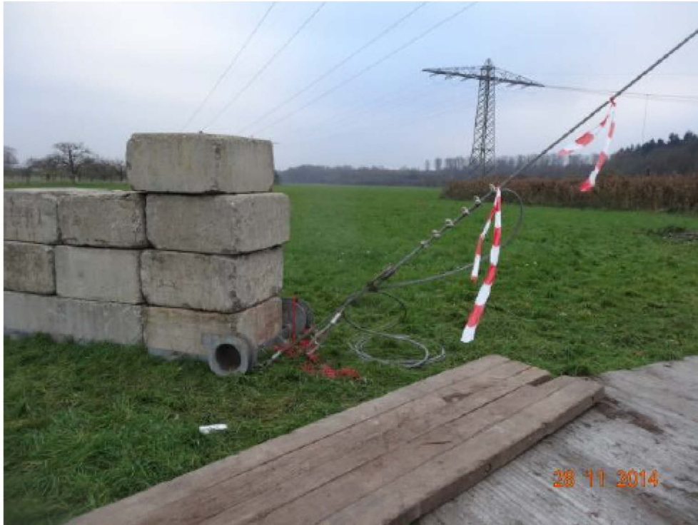
Abbildung 42: Verankerung mit Gewichtsschlitten
