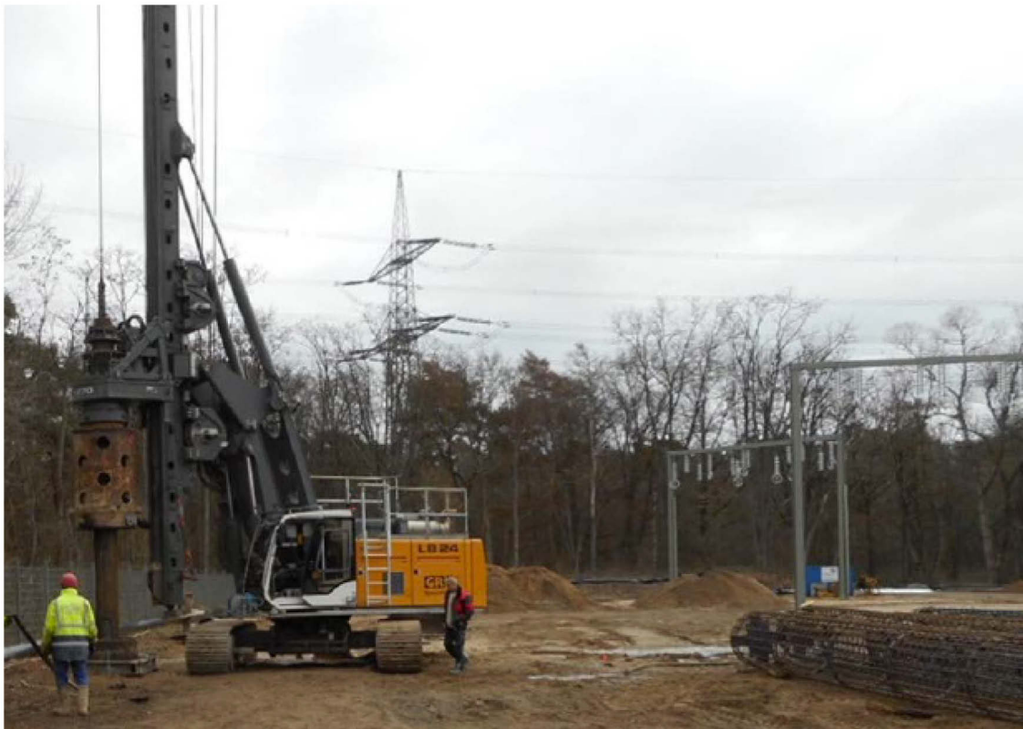
Abbildung 31: Bohrerät für Bohrpfahlgründung mit liegenden Bewehrungskörben
