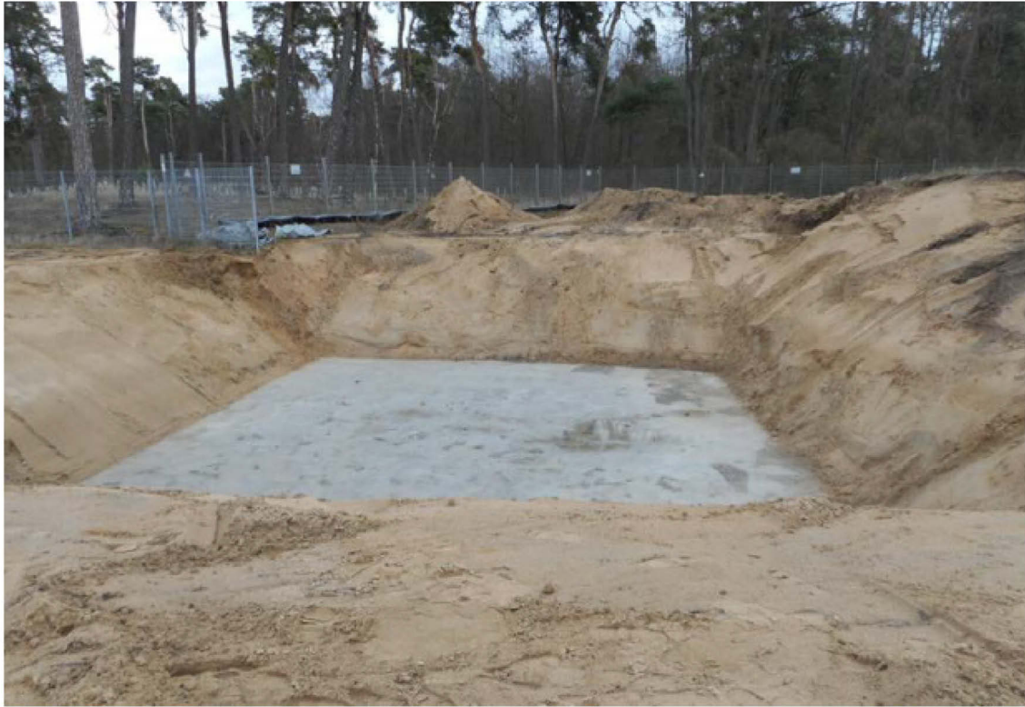
Abbildung 33: Geböschte Baugrube mit eingebrachter Sauberkeitsschicht
