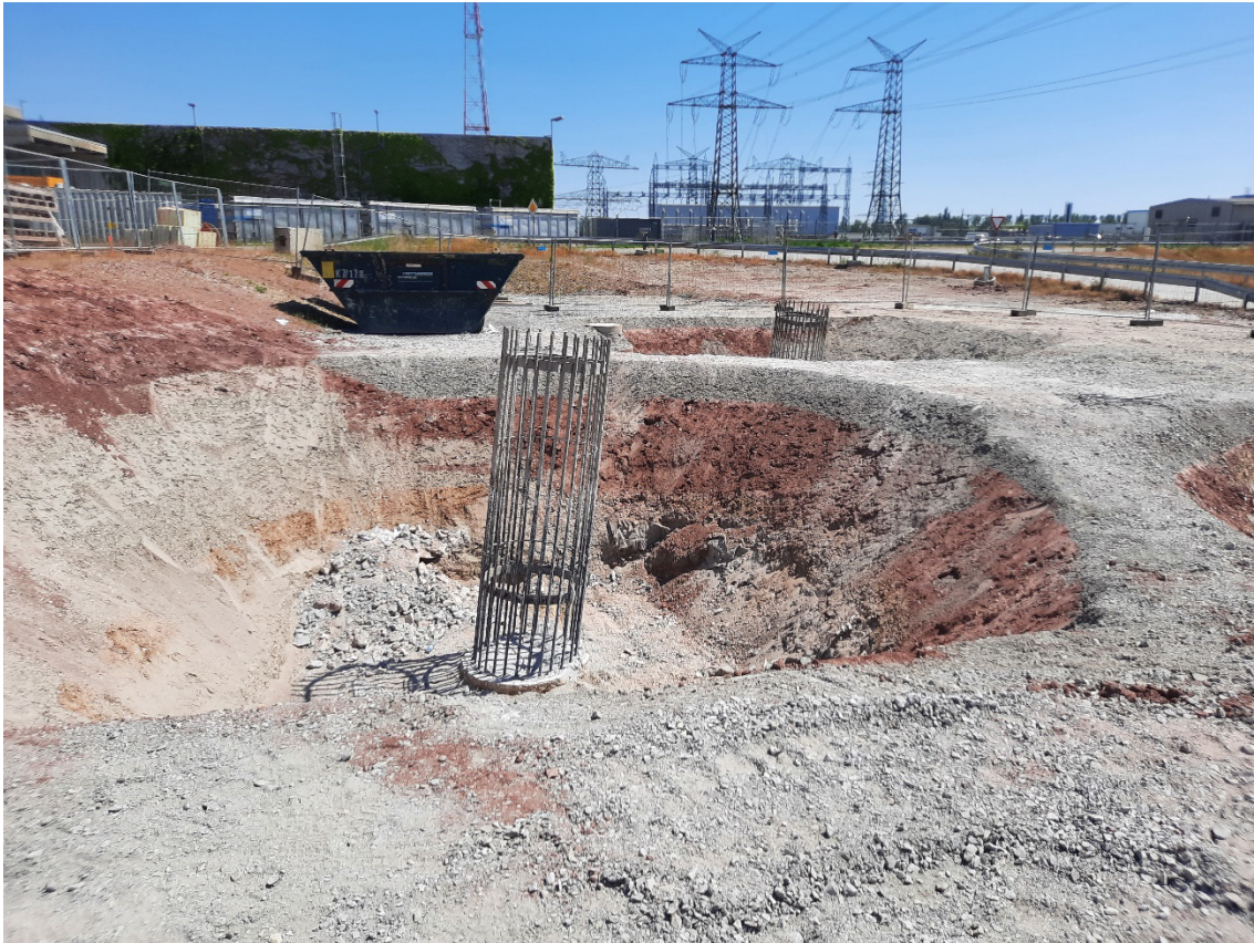
Abbildung 32: Baugrube mit Bohrfahlgründung und eingebrachtem Bohrfahl Quelle: LTB Leitungsbau GmbH
