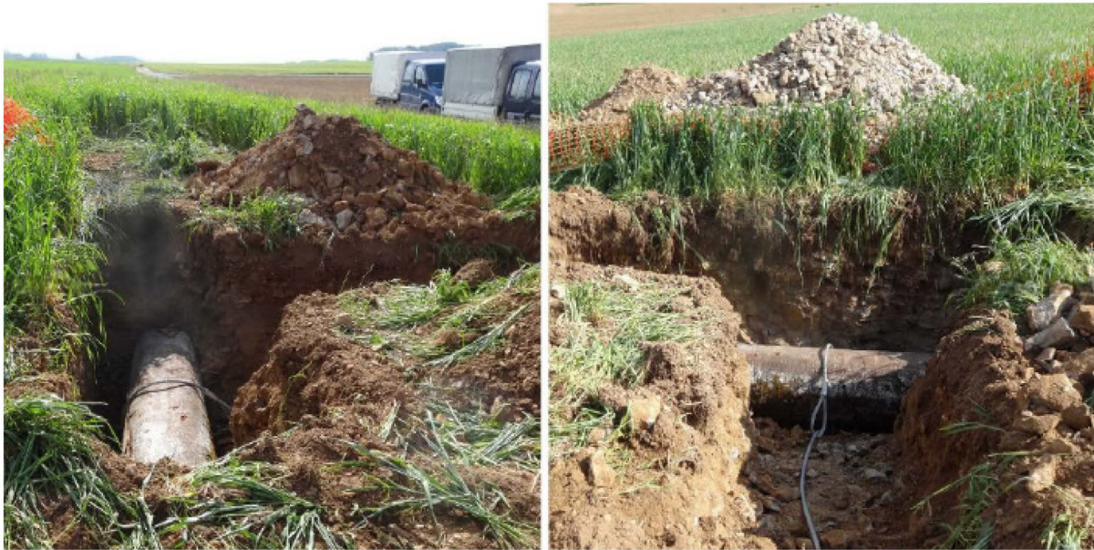
Abbildung 44: Beispiel „Totmann-Anker“ während des Einbaus Quelle: LTB Leitungsbau GmbH
