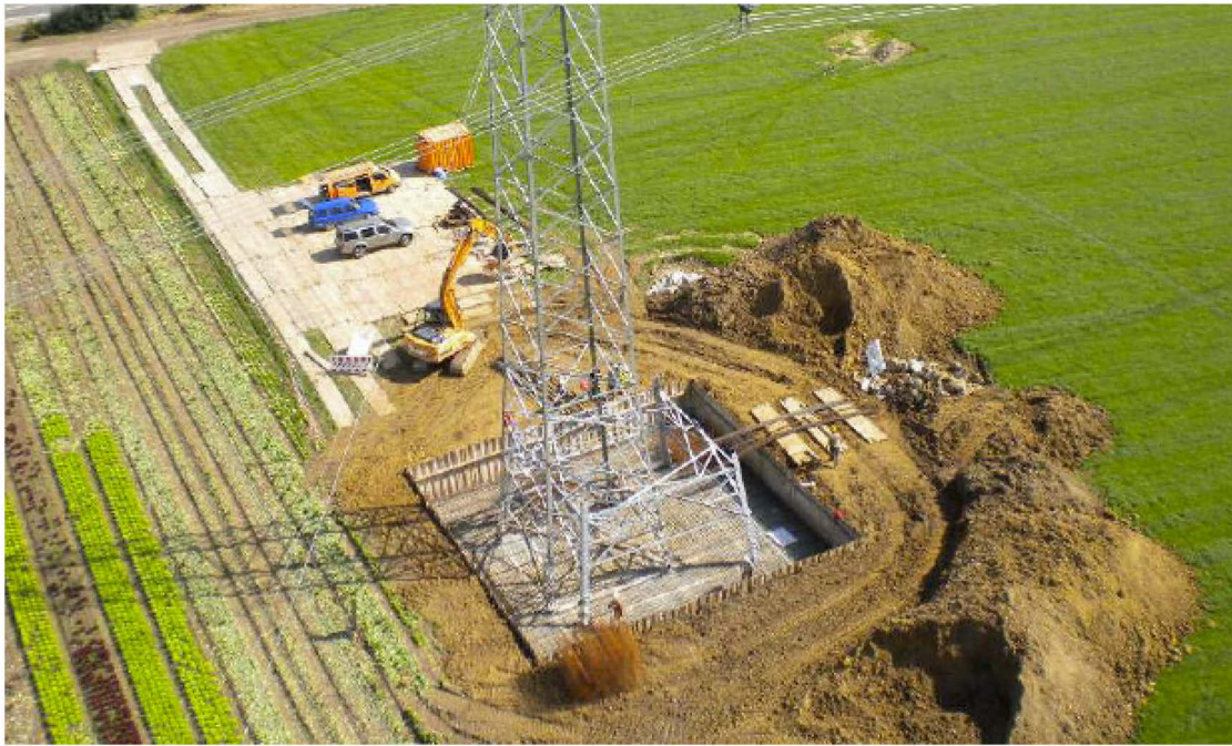
Abbildung 29: Beispiel einer Baustelleneinrichtungsfläche mit Fundamentgrube (standortgleicher Ersatzneubau)
