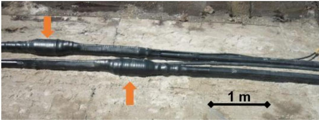
Abbildung 12: Muffen (Pfeilmarkierung) vor Wiederverfüllung des Leitungsgrabens
