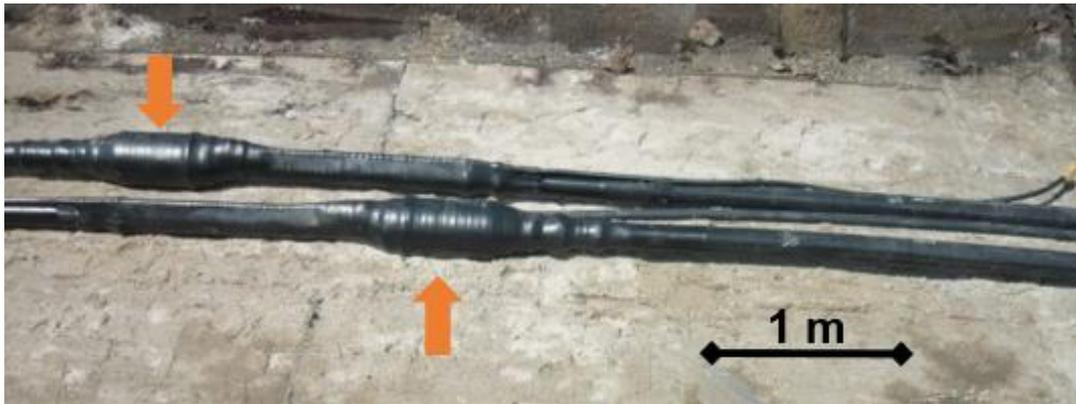
Abbildung 12: Muffen (Pfeilmarkierung) vor Wiederverfüllung des Leitungsgrabens
