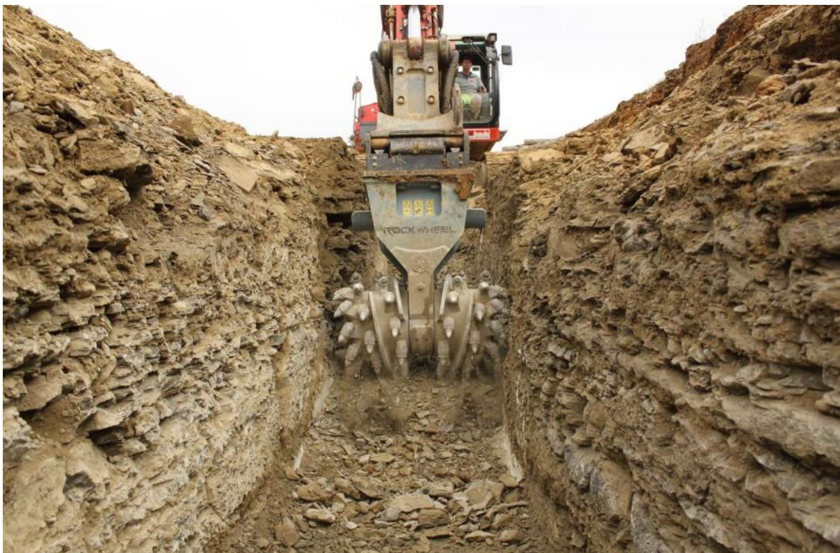
Abb. 2-7: Anbaufräse (Bagger) zur Grabenherstellung (Quelle: www.baumaschinendienst.de ).
