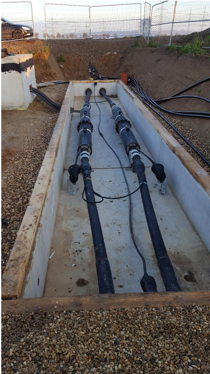
Abb. 2-3: Beispiel Muffenverbindung.
