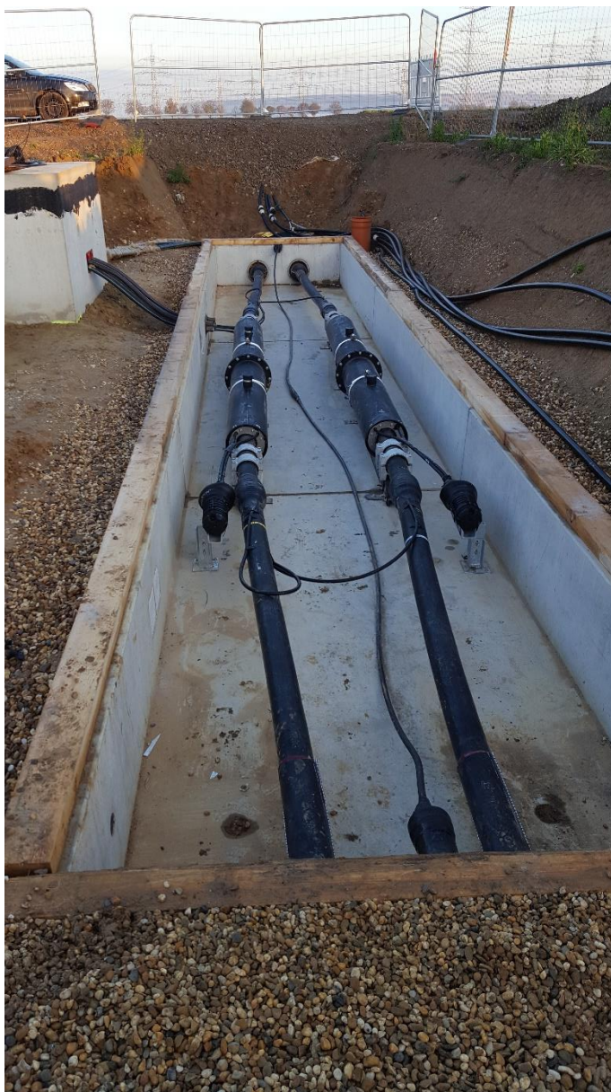
Abb. 2-3: Beispiel Muffenverbindung.
