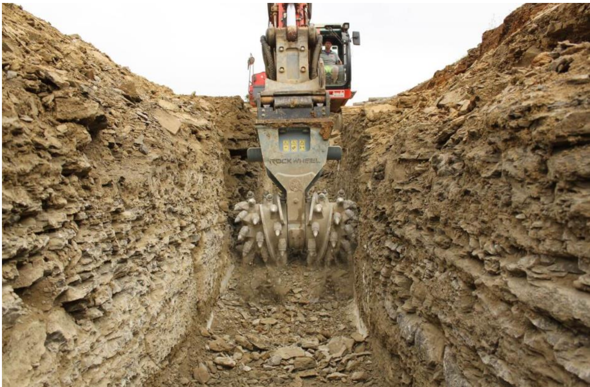
Abb. 2-7: Anbaufräse (Bagger) zur Grabenherstellung (Quelle: www.baumaschinendienst.de ).
