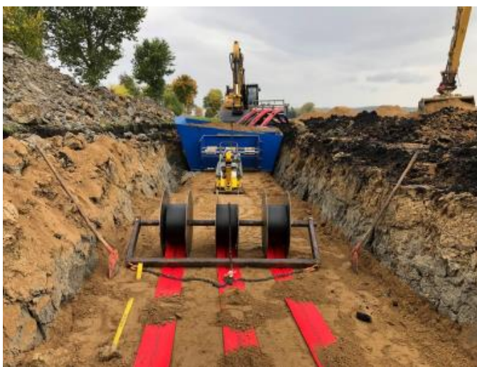
Abb. 2-8: Ansicht Trenchbox aus dem Graben; Drehstrom-Projekt (3 Schutzrohre) (Quelle: TenneT TSO GmbH).
