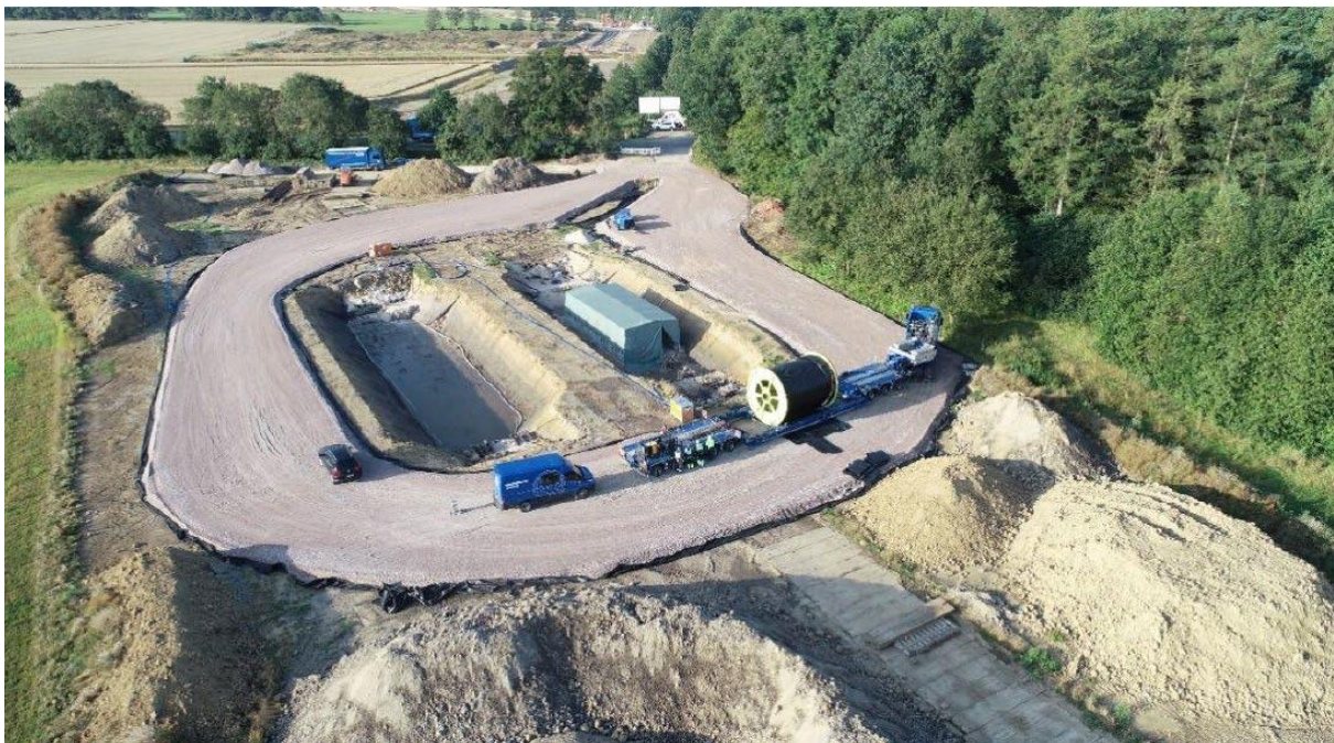
Abb. 2-4: Trommelplatz für ein Erdkabelvorhaben mit zwei Systemen (Quelle: Wassermann Gruppe).
