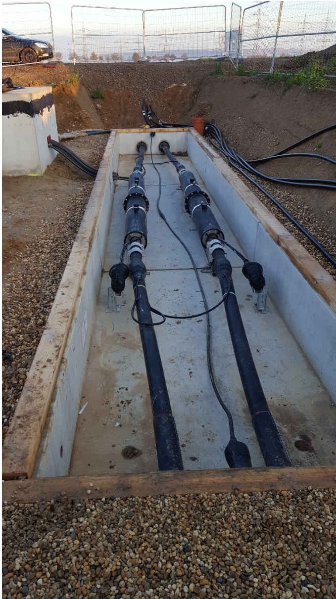
Abb. 2-3: Beispiel Muffenverbindung.
