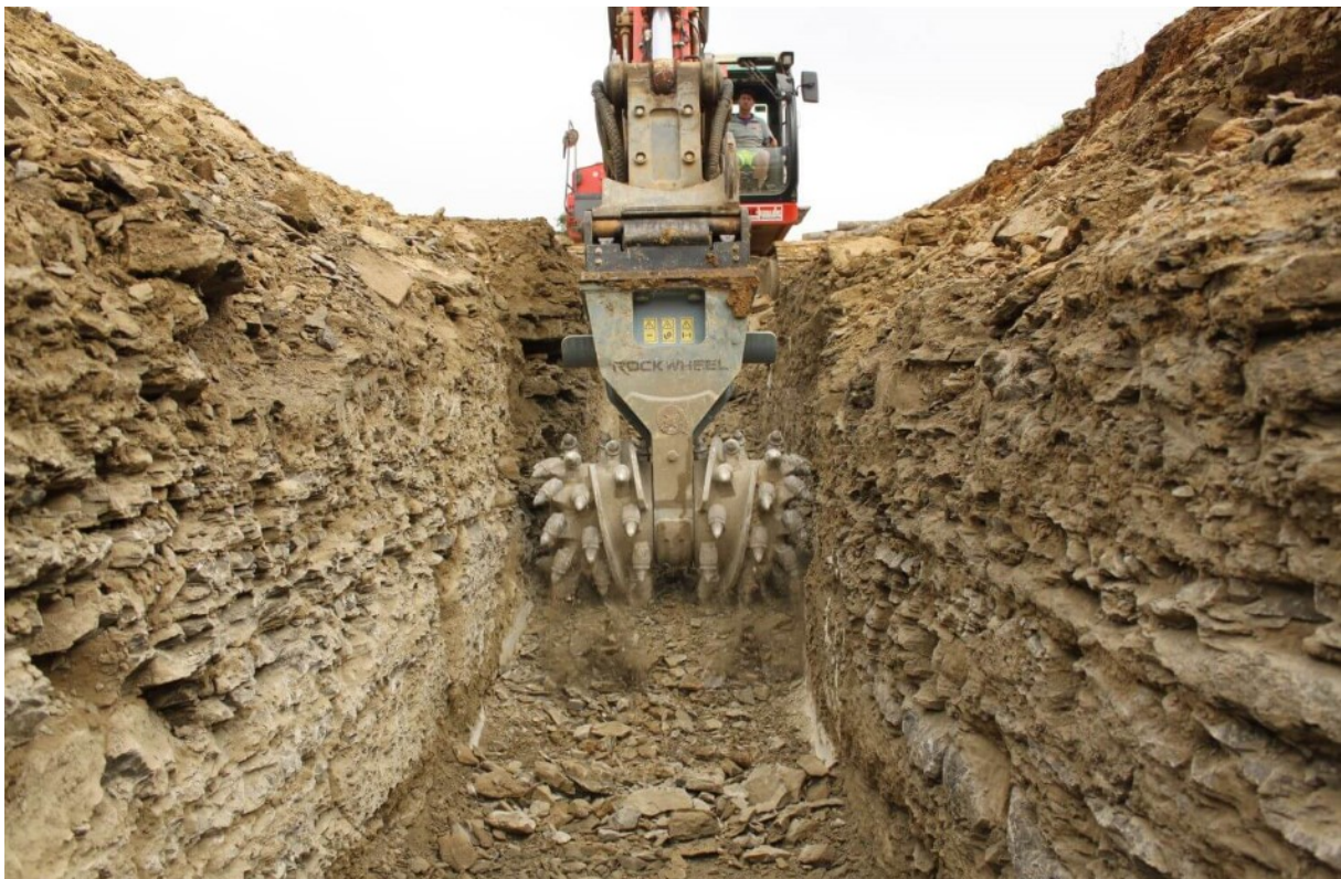
Abb. 2-7: Anbaufräse (Bagger) zur Grabenherstellung (Quelle: www.baumaschinendienst.de ).
