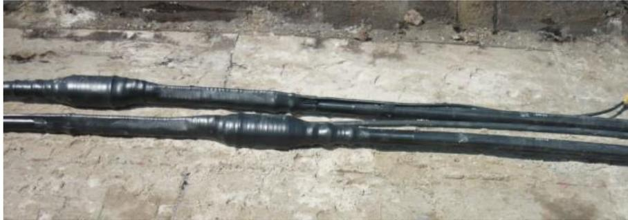
Abb. 7: Fertige Muffen vor dem Verfüllen mit Bettungsmaterial
