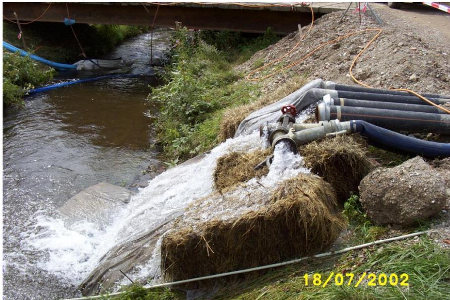
Abb. 17: Einleitung des geförderten Grundwassers in einen Vorfluter
